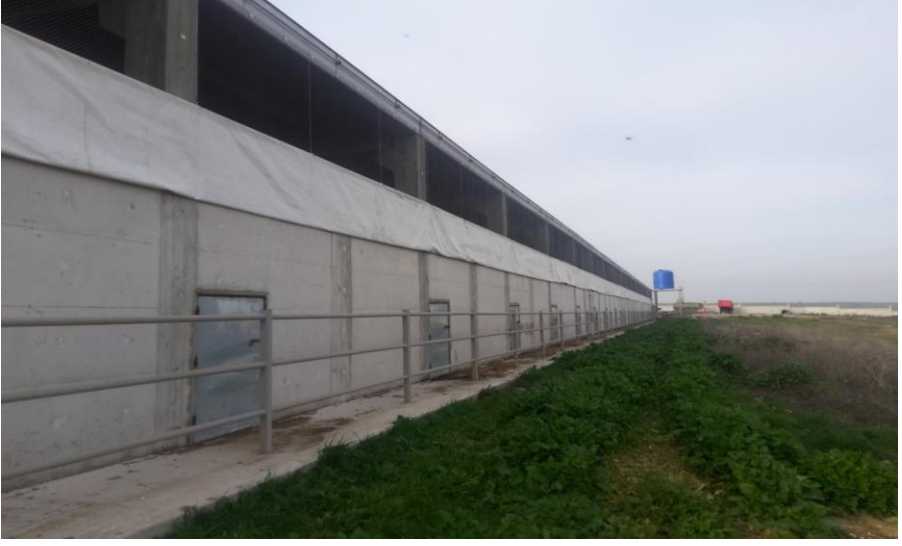
Şekil 4. Barınak-1, I. Kısım ızgara tabanlı ahırın dıştan görünümü
