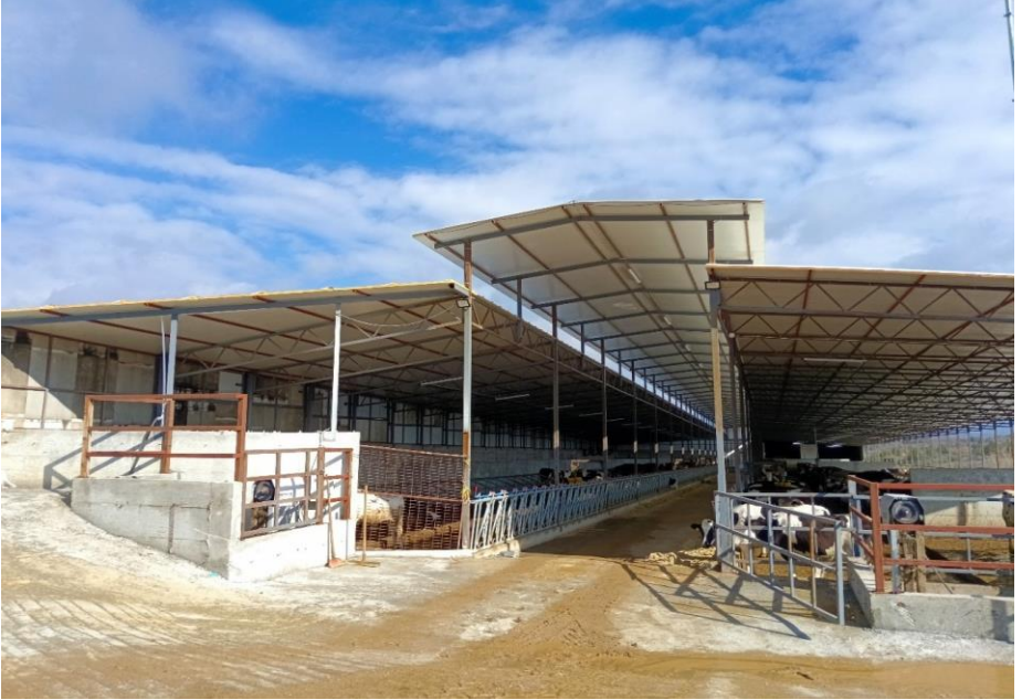
Şekil 13. Barınak-2, I. Kısım, serbest-duraklı süt sığırı ahırının dıştan genel görünümü
