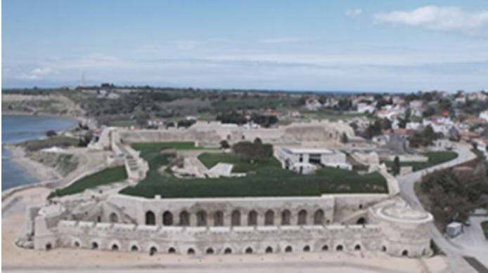
Şekil 10. Restorasyon Sonrası (URL 4)
