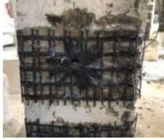
Şekil 3: Kolonların TRM ile güçlendirilmesi
