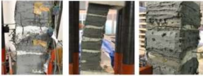
Şekil 1: Kolonların hasar mekanizmaları örneği
